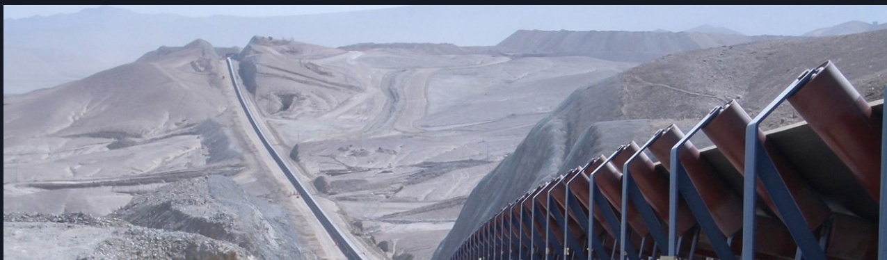
Transporte de material ( overland conveyor vs camiones )
