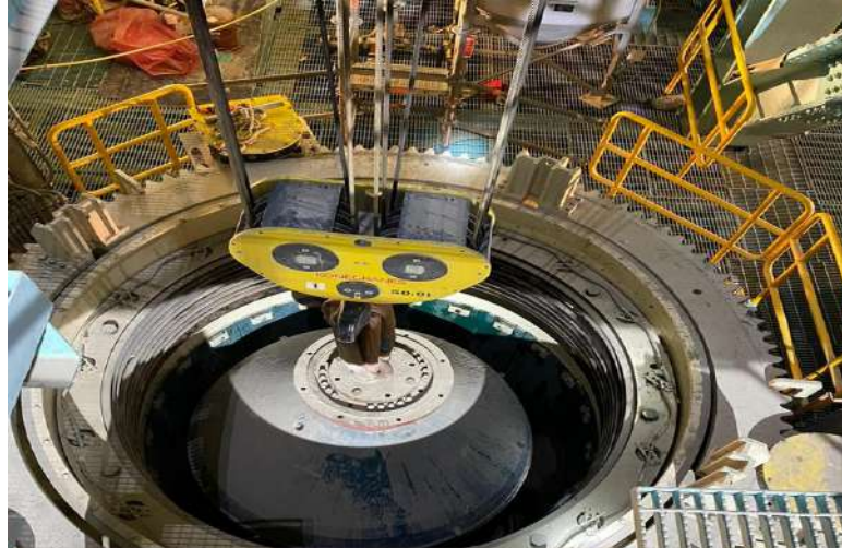
Trabajos de término mecánico de chancador secundario
