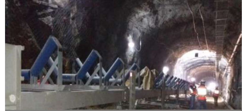
Montaje en túneles
