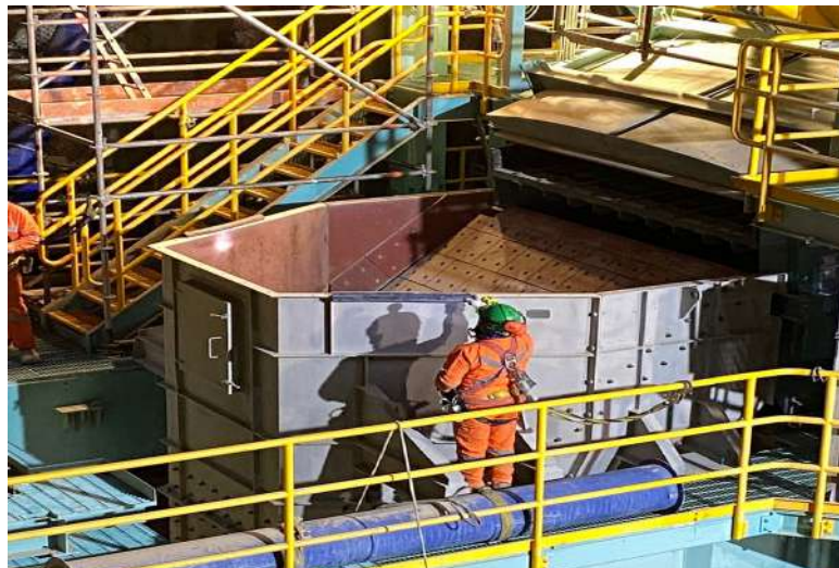
Montaje chute de descarga chancado secundario
